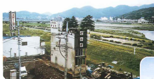
△ 建物移転工事
