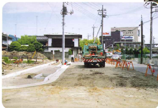
△ 道路築造工事
