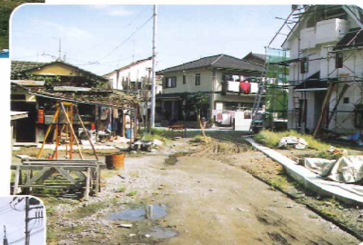
△ 建物建築工事
