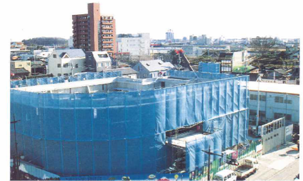
△建物建築工事
