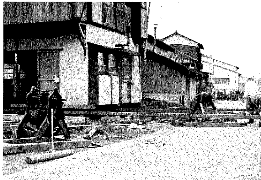
建物曳去工事
