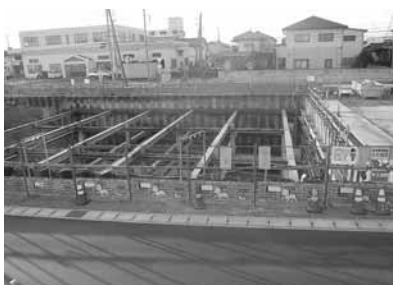
▲市道鹿島山下通り道路改良工事の様子
