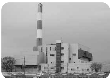
▲南部クリーンセンター
