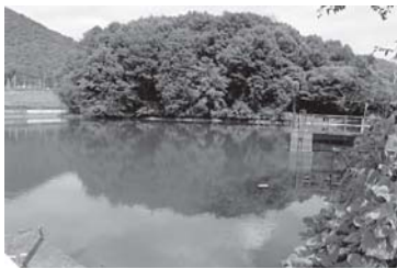
▲市内にあるため池
