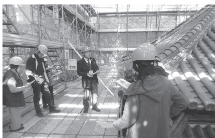
▲足利学校大成殿の保存修理工事の見学会
