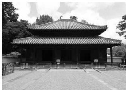
▲改修を行う足利学校大成殿
