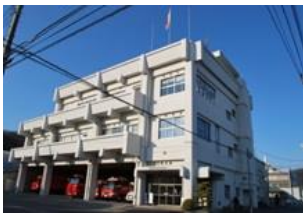
工事開始予定 H31(2019)～
