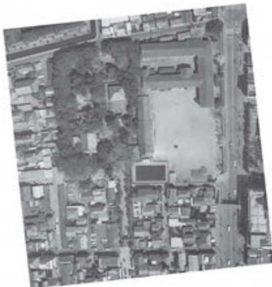
第1次保存整備事業前の状況
