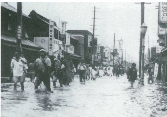
浸水した街中を歩く人々(通2丁目)
