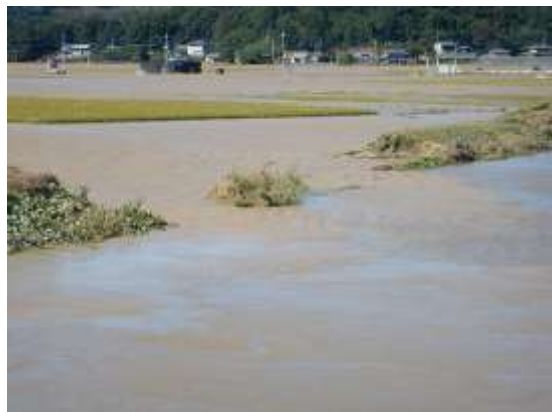
奥戸町 出流川の破堤箇所
