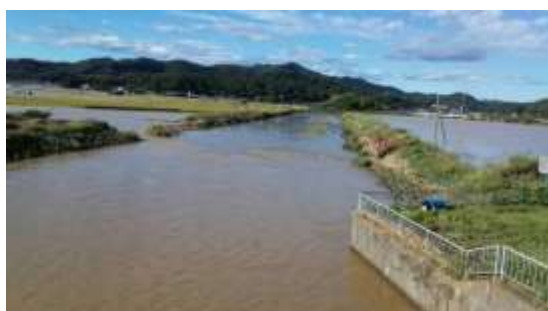
決壊した出流川(寺岡町)
