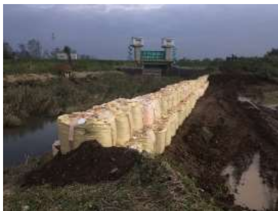
奥戸町 出流川の破堤仮復旧
