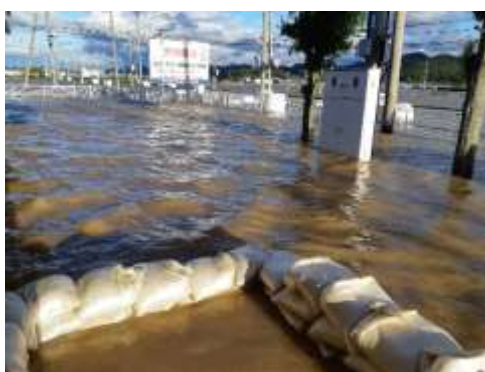
川崎町 東分署北側駐車場
