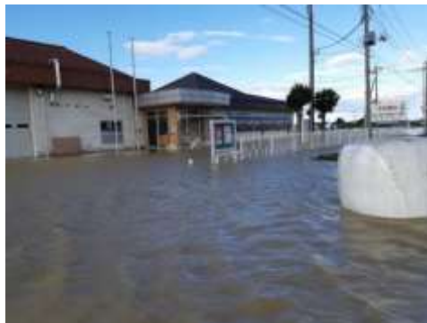
毛野東部工業団地、東分署の冠水
