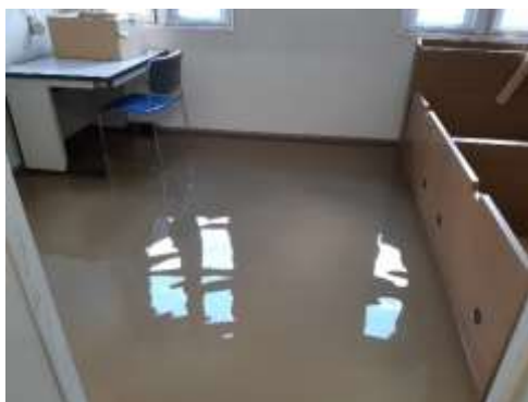
東分署仮眠室
