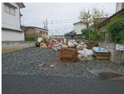
一次仮置場（助戸1丁目）
