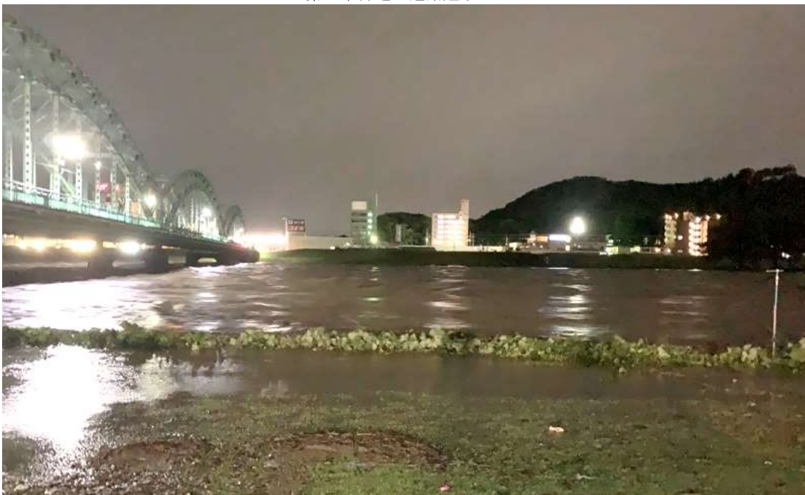
渡良瀬川中橋付近の増水
