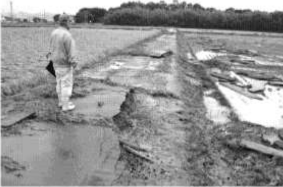
アスファルトがはがされた稲岡町の農道。土砂などが農地に流れ込んだ
