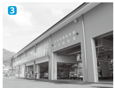
消防本部新庁舎
