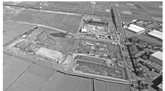
▲造成、分譲が進むあがた駅南産業団地
