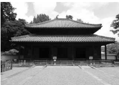
▲改修を行う足利学校大成殿
