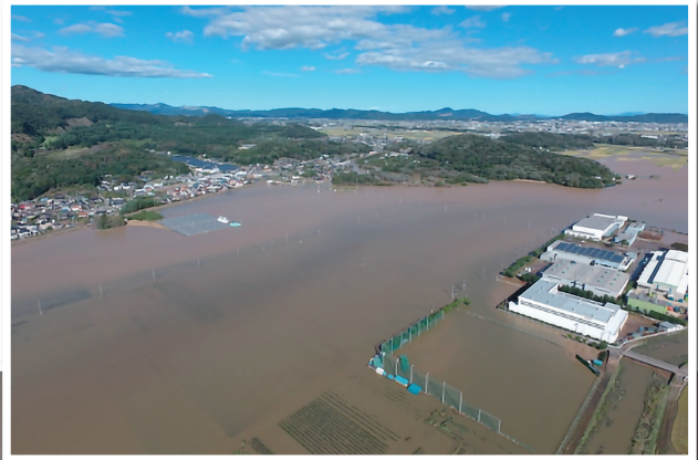
▼ 令和元年東日本台風の被害の様子。
